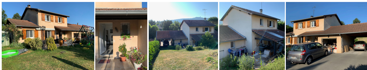
photos avant travaux
